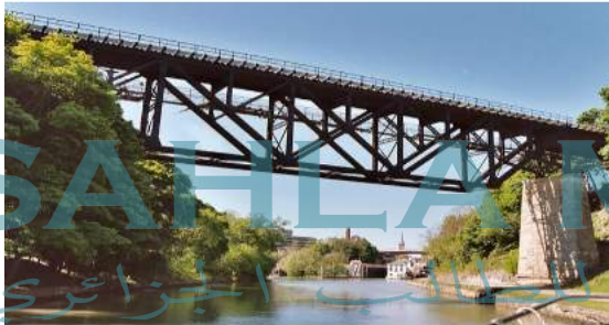
Pont à tablier supérieur, sur le Canal Erié
