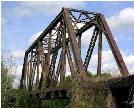
Pont à treillis de type Warren de la ligne ferroviaire « Seaboard Air Line Railway », situé près du village de Willow, Floride.
