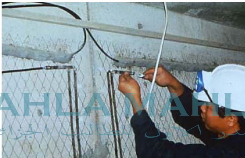
Mise en place du treillis anodique
