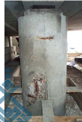
Pile de pont
