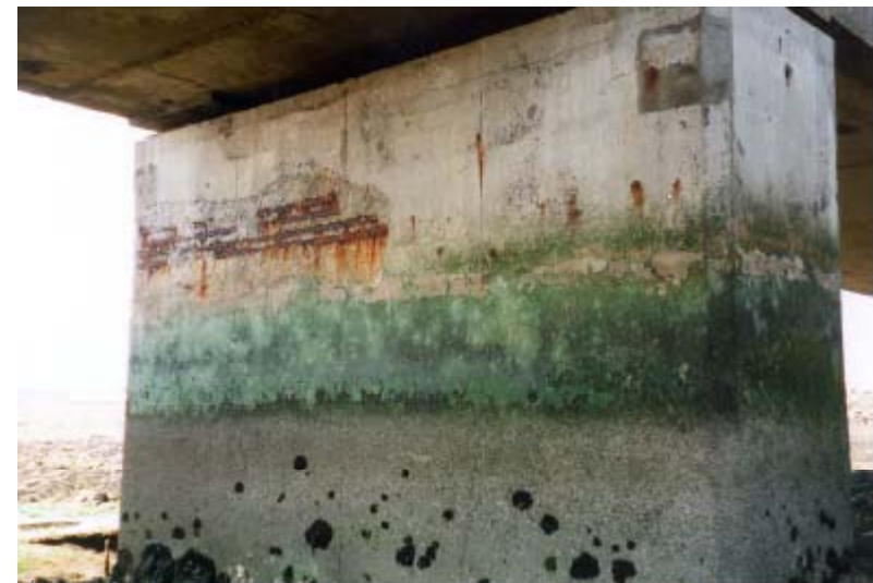
Pile en zone de marnage
