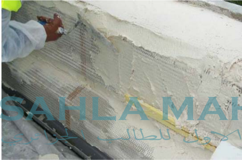
Application de la pâte sur le treillis
