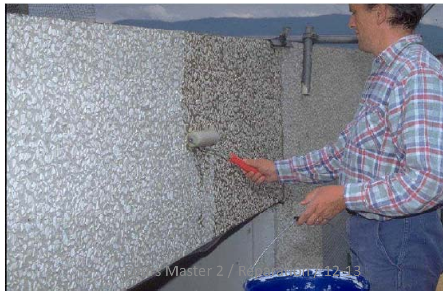
Application d'inhibiteur
