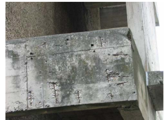
Parement en béton armé dans un monastère classé
