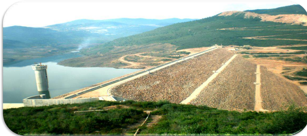
Fig. 18. Barrage en terre
