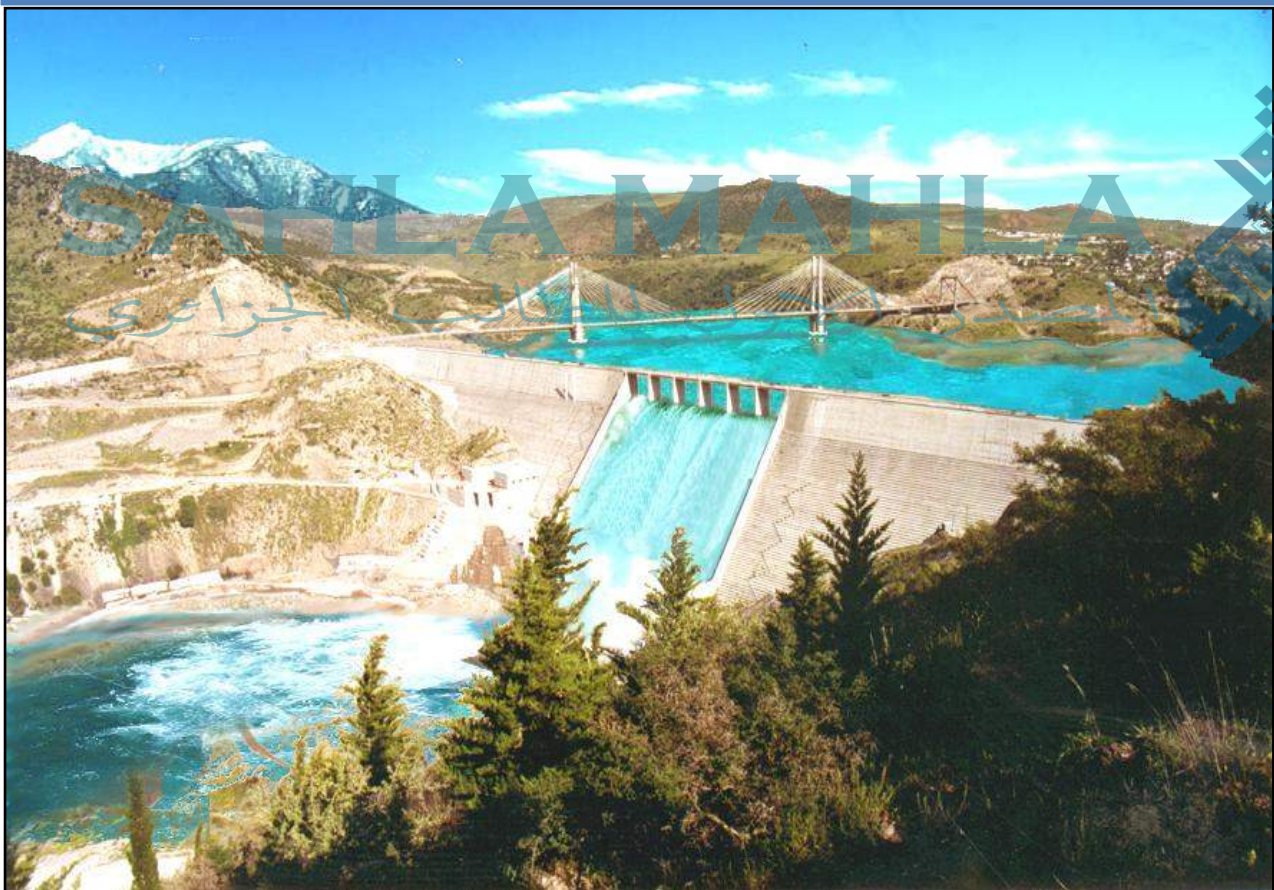
Barrage en BCR : BENI HAROUN - ALGERIE
